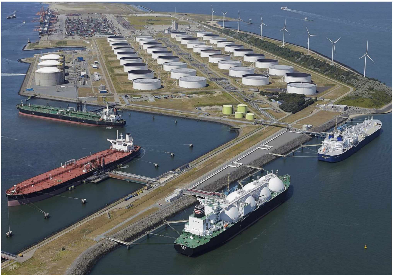
Figuur 3-1: Luchtfoto Gate terminal met locatie van jetty 1, 2 en achter de opslagtanks jetty 3, bron: www.gate.nl
