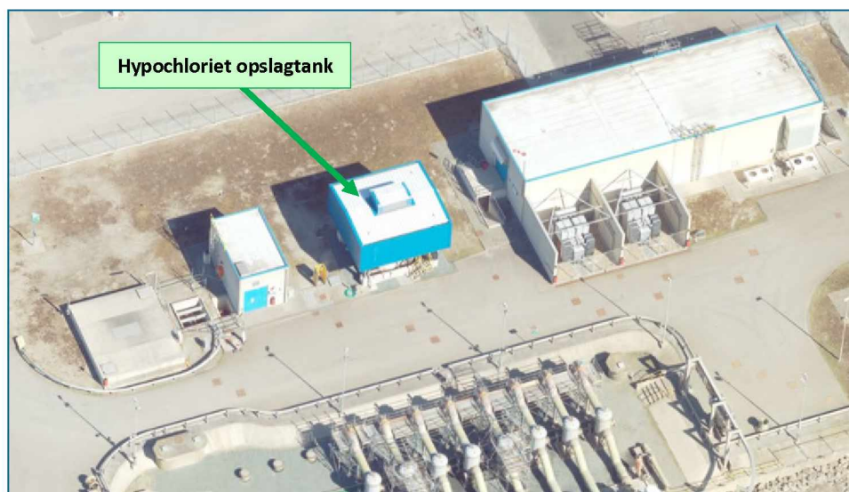
Figuur 4.1 pompstation terrein (bron: cyclomedia)
