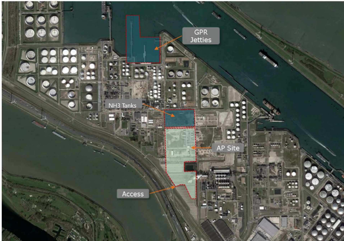
Figuur 2: Locatie AP-site, NH 3 tanks en GPR Jetties
