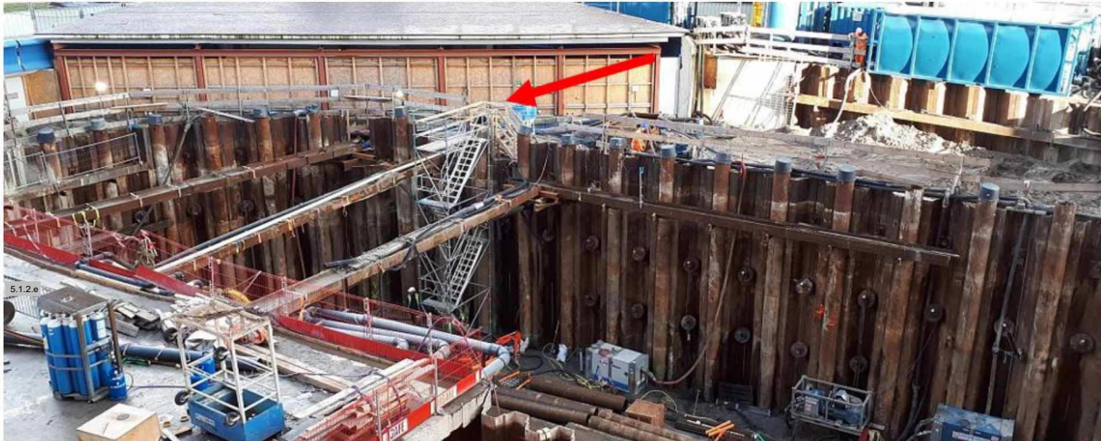
Figuur 3: Trappentoren bouwkuip
